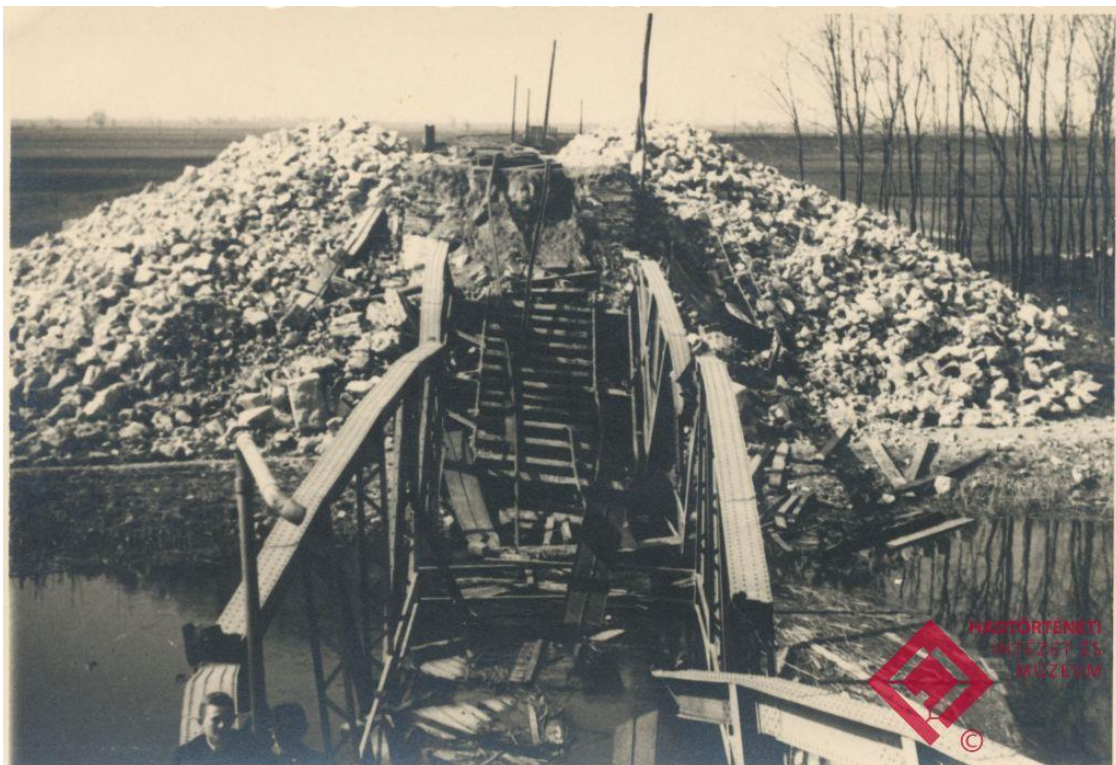
/HTM 88 346 Felrobbantott híd a Ferenc József-csatornán Kiszács és Újvidék között/
