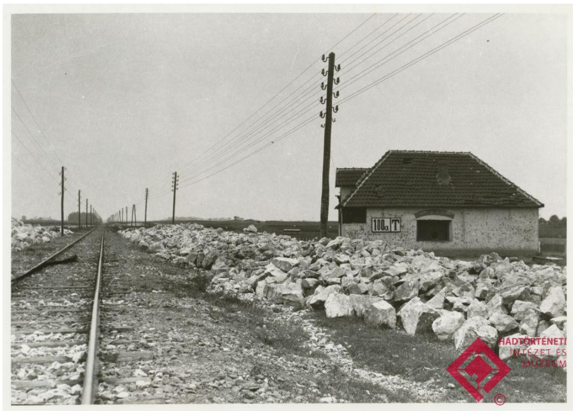
/HTM 86 188 Vasúti őrháznak álcázott közepes vasbeton erőd, akadályokkal/
