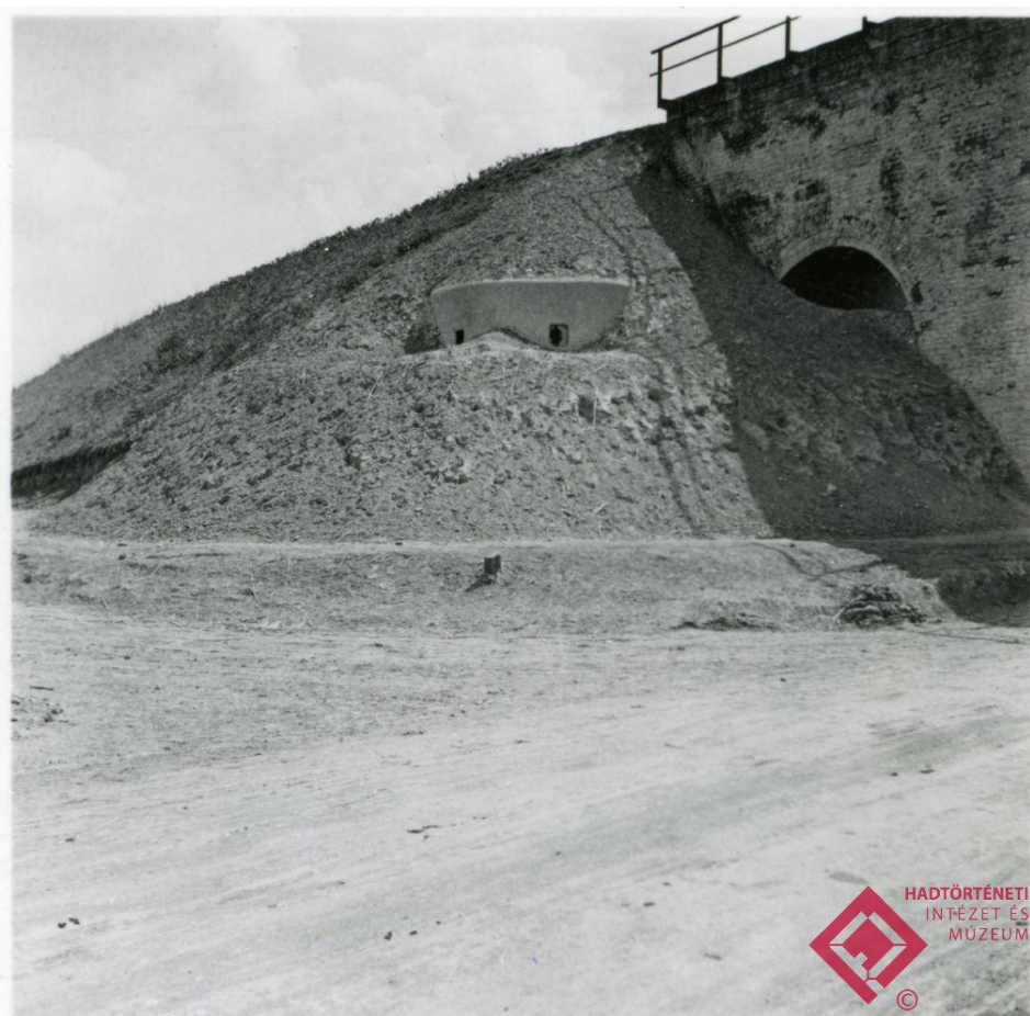
/HTM 97 584 Vasúti átjárót biztosító vasbeton bunker Kulánál/
