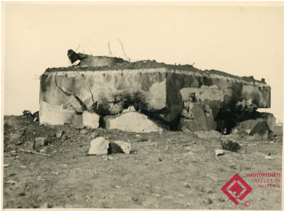
/HTM 96 844-186 Szétlőtt nagy vasbeton erőd/
