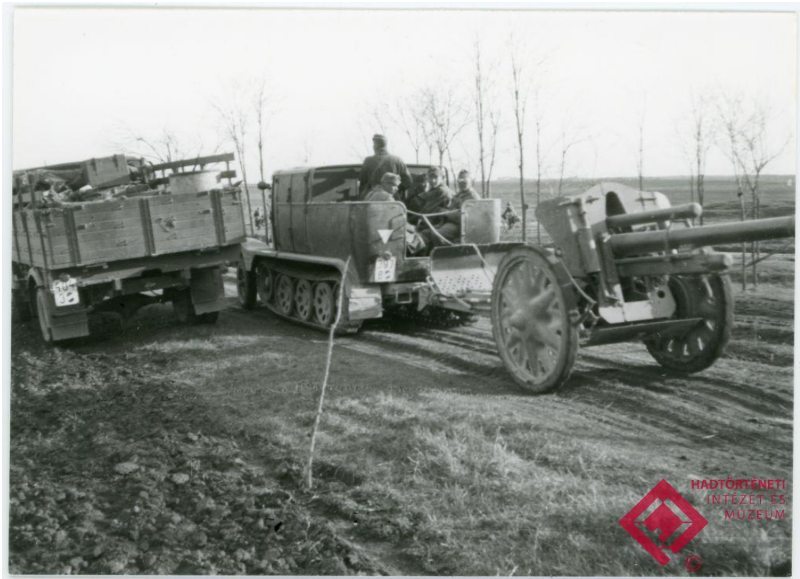
/HTM 106 314-87 Gépvontatású tüzérség. Német 1937 M 10,5 cm-es tarack Hansa Lloyd közepes tüzérségi vontatóval/
